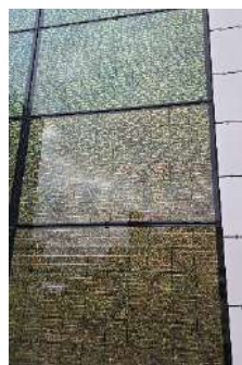
Figura 4. Disposición de paneles en fachadas con orientación Sur. Fuente: Elaboración propia. Detalle de sujeción del vidrio FV en la fachada ventilada. Fuente: Fachadas - Soluciones Constructivas de Onyx Solar
