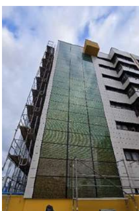
Figura 6. Detalle de la actuación en las fachadas de la comunidad, visión del antes y después con la instalación de fachada Ventilada y Solar Fotovoltaica. Fuente: Elaboración propia.
