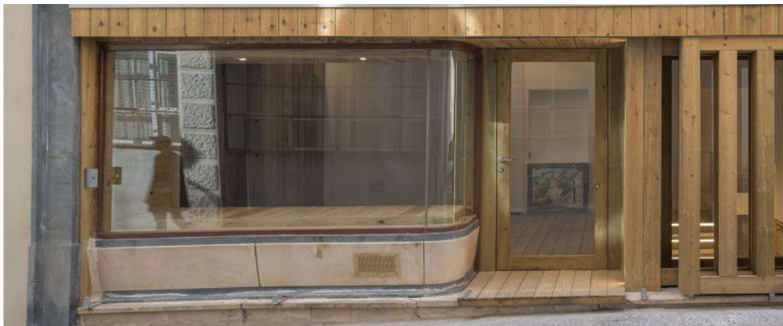
Figura 4. Trastámara nº 9. Escaparate histórico recuperado y celosía corredera. Fuente: Imagen Subliminal. 2024
