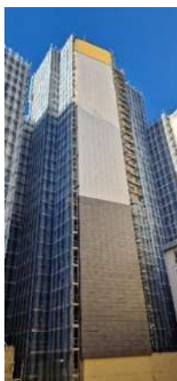
Figura 6. Detalle de la actuación en las fachadas de la comunidad, visión del antes y después con la instalación de fachada Ventilada y Solar Fotovoltaica. Fuente: Elaboración propia.
