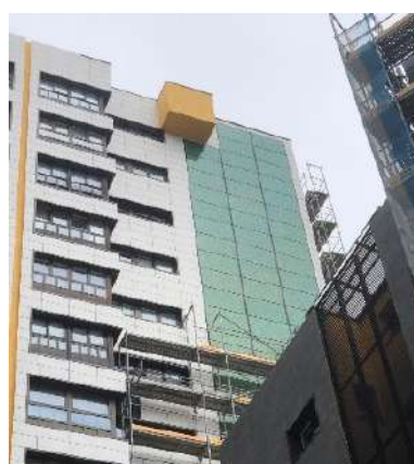
Figura 6. Detalle de la actuación en las fachadas de la comunidad, visión del antes y después con la instalación de fachada Ventilada y Solar Fotovoltaica. Fuente: Elaboración propia.
