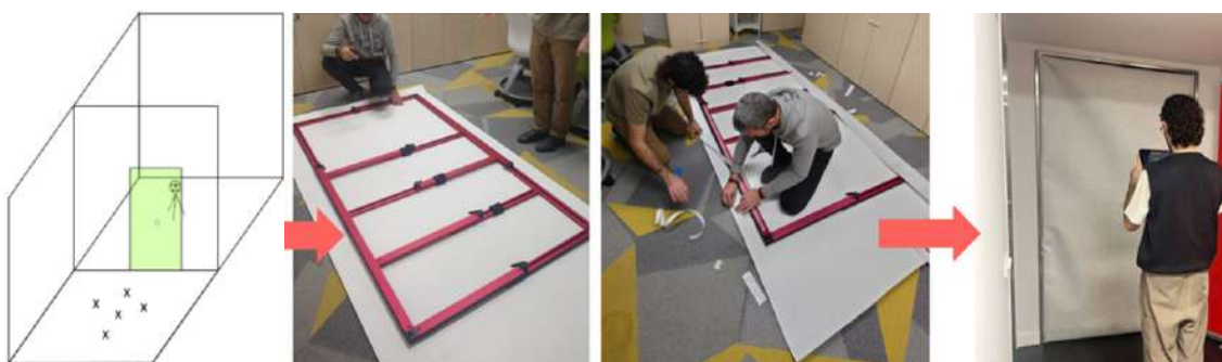
Figura 3. Montaje del apantallamiento total sobre el hueco de puerta abierta. Fuente: "Elaboración propia".
